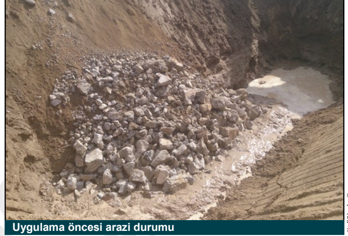
Uygulama öncesi arazi durumu
