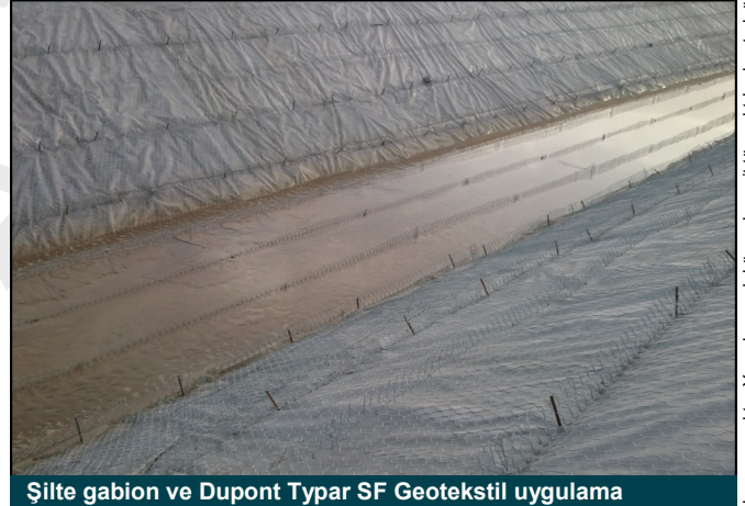
Şilte gabion ve Dupont Typar SF Geotekstil uygulama
