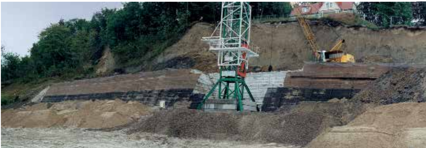
54. Şev stabilizasyonu, Jastrzebiej Gorze - Polonya
