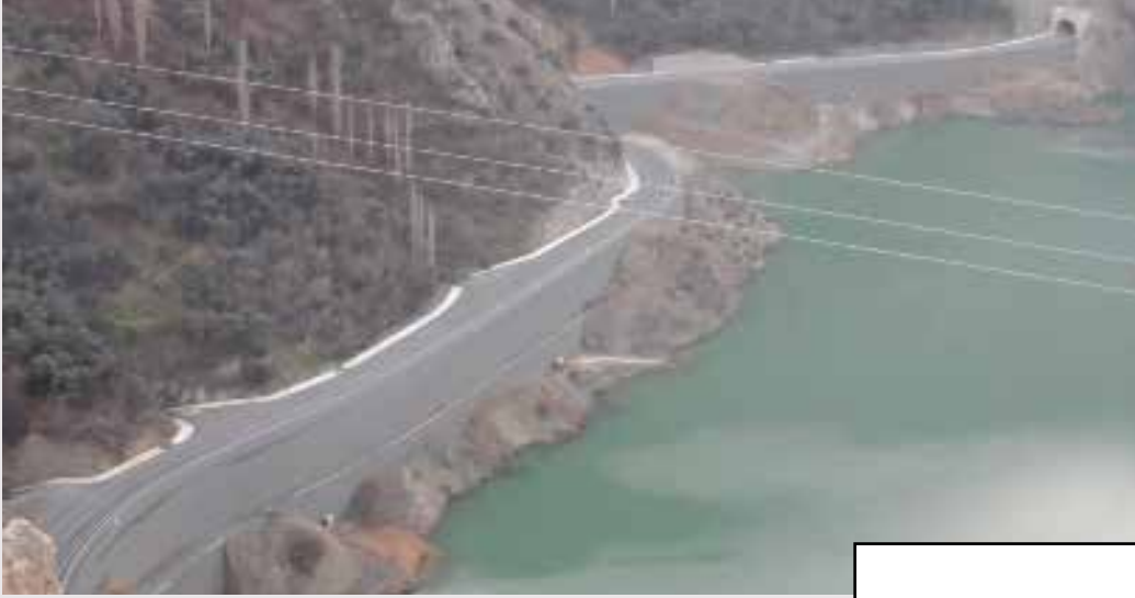
18-19. Geosentetik Donatılı Terramesh İstinat Duvarı Artvin Barajı ve Hidroelektrik Santrali Artvin - Türkiye
