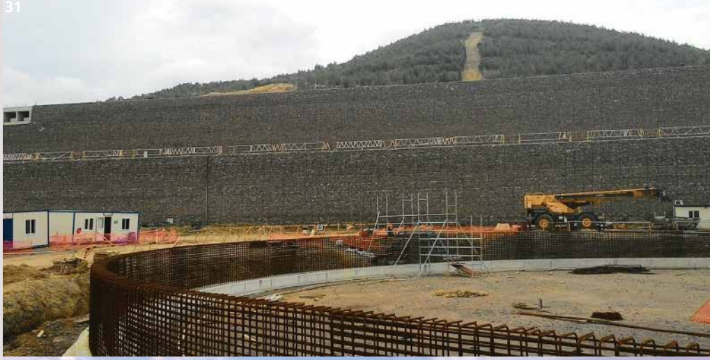
31 -32 . Terramesh®sistem istinat duvarı uygulaması İzmir-Türkiye
