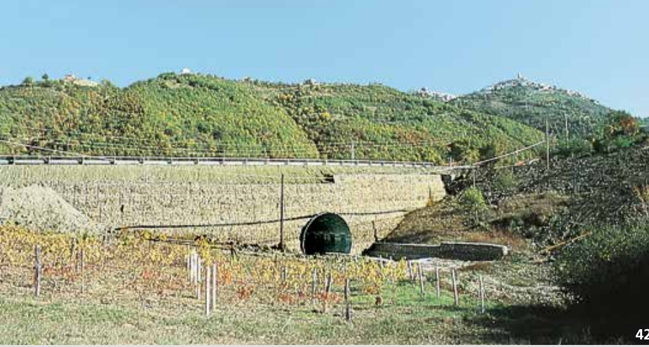
40-41. Geogridlerle şev stabilizasyonu, Tapei - Tayvan.
