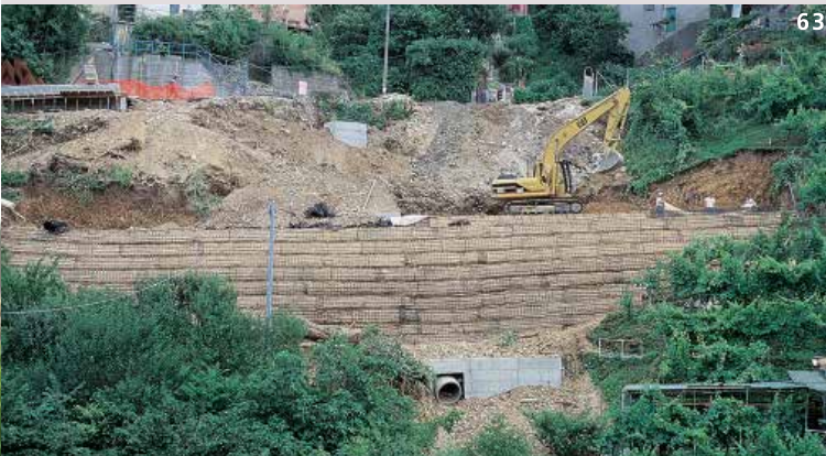
63. Yol Genişletme için geogrid istinat yapısı, Arcola (SP) - İtalya.
