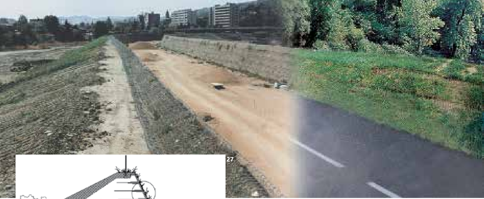
27 - 28. Şehir içinde gürültü bariyeri olarak kullanılan Yeşil Terramesh®, Bologna-İtalya.
