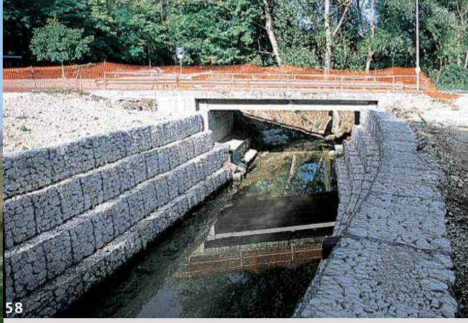
58. Terramesh® S ve gabionlarla hidrolik koruma, Vella nehri, Sulmona (AQ) - İtalya.
