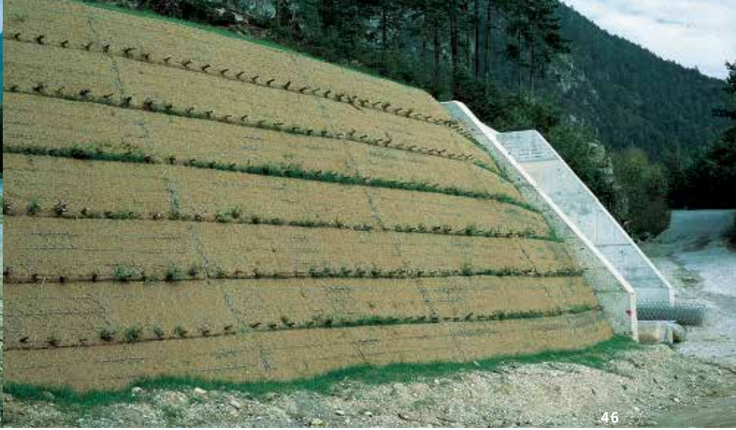
45 - 46. Yeşil Terramesh® ile istinat duvarı ve hidrolik işler Ugovizza (UD) - İtalya.
