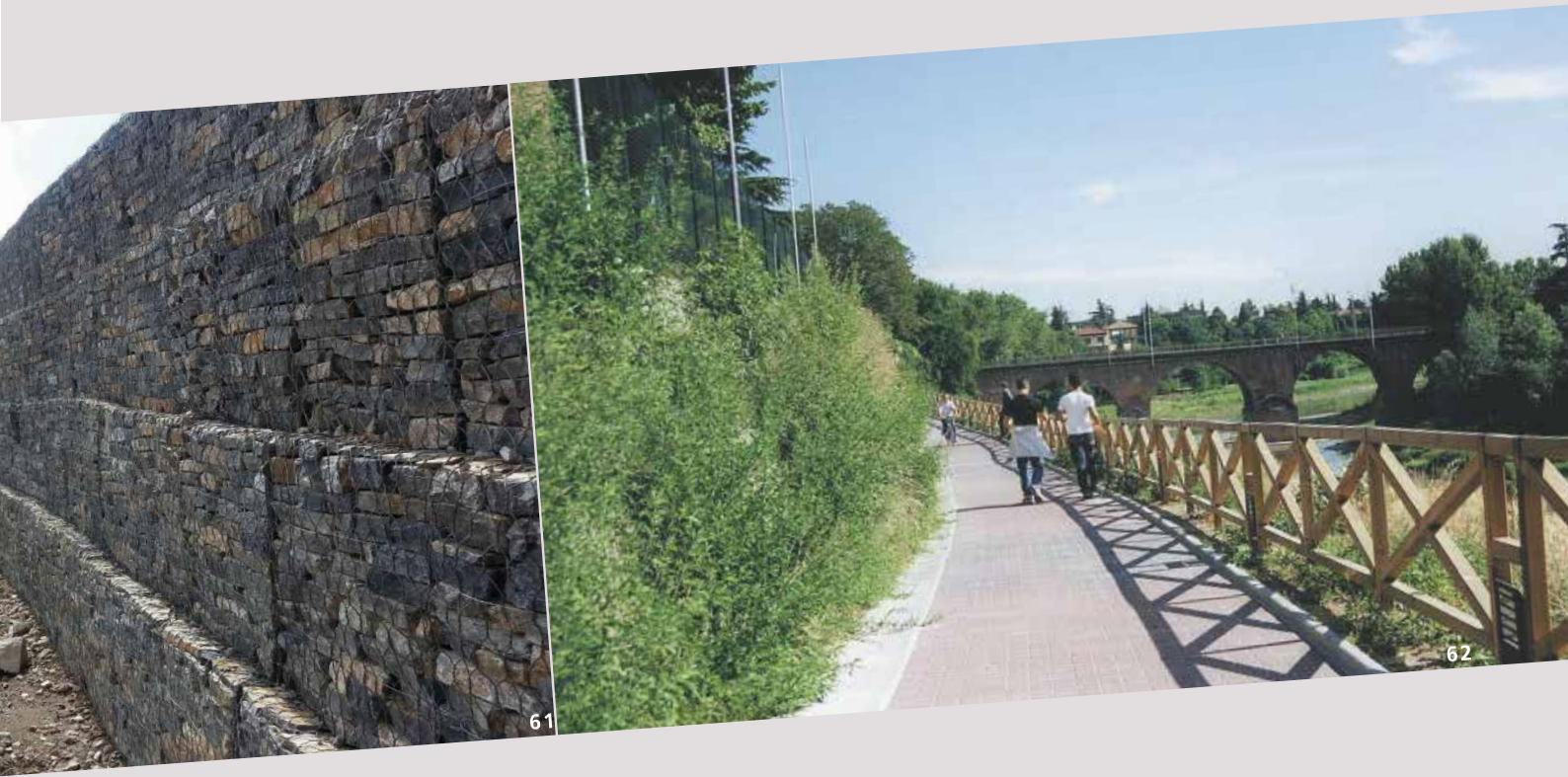
64. Yeşil Terramesh® ile nehir kıyısı koruması, Cogne (AO) - İtalya.
