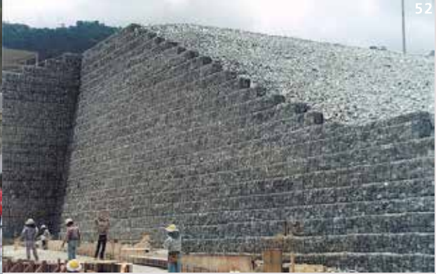
50. Yeşil Terramesh® ile yeni park alanı için istinat duvarı Ariccia (RM) - İtalya.
