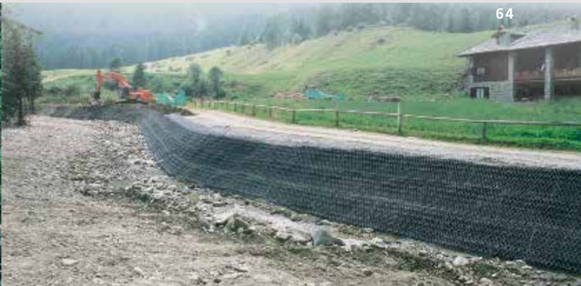
64. Yeşil Terramesh® ile nehir kıyısı koruması, Cogne (AO) - İtalya.
