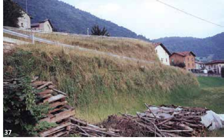
35 - 36 - 37. Yeşil Terramesh® kullanılarak yolun yeniden düzenlenmesi Valled'Ogna (BG) - İtalya.
