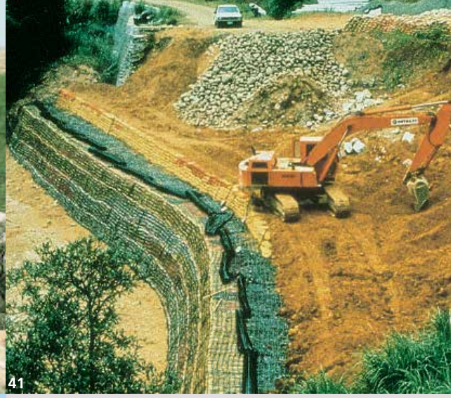
40-41. Geogridlerle şev stabilizasyonu, Tapei - Tayvan.
