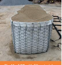
FlexMac<sup>®</sup> DT with fill material
